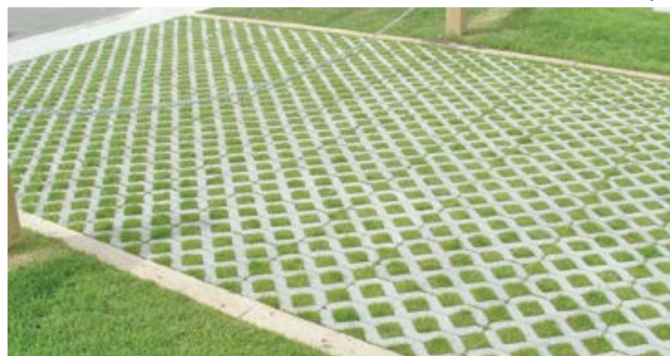
O grama é como uma moldura de concreto que permite o cultivo de grama no centro.
