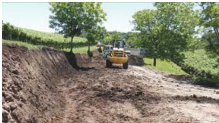
A comunidade do Paredes está em obras no sentido Travessão Alfredo Chaves, no limite com Flores da Cunha.
